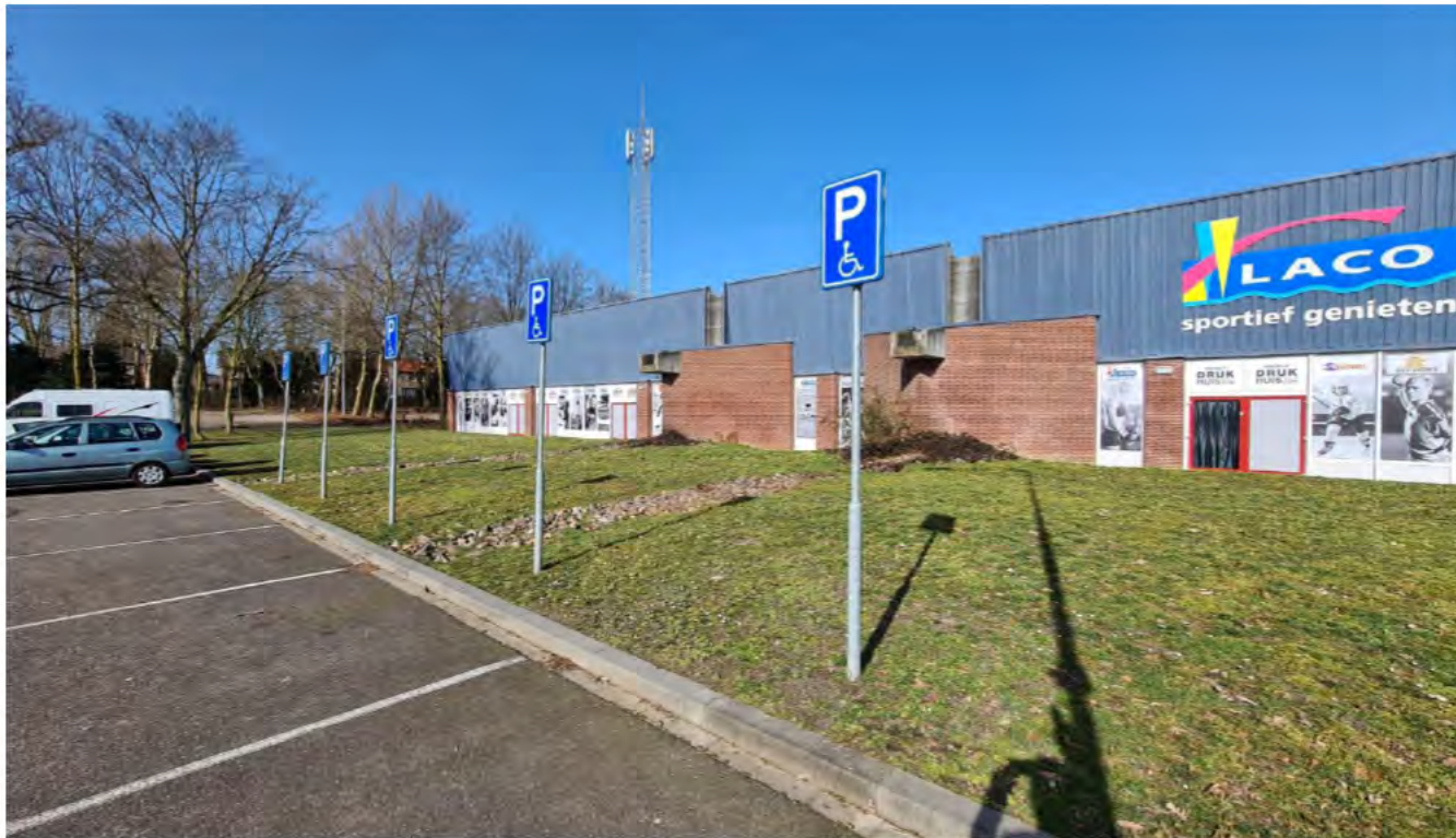
Figuur 4: Zuidelijke gevel bestaande sportaccommodatie gezien vanaf de zuidelijke parkeerplaats
