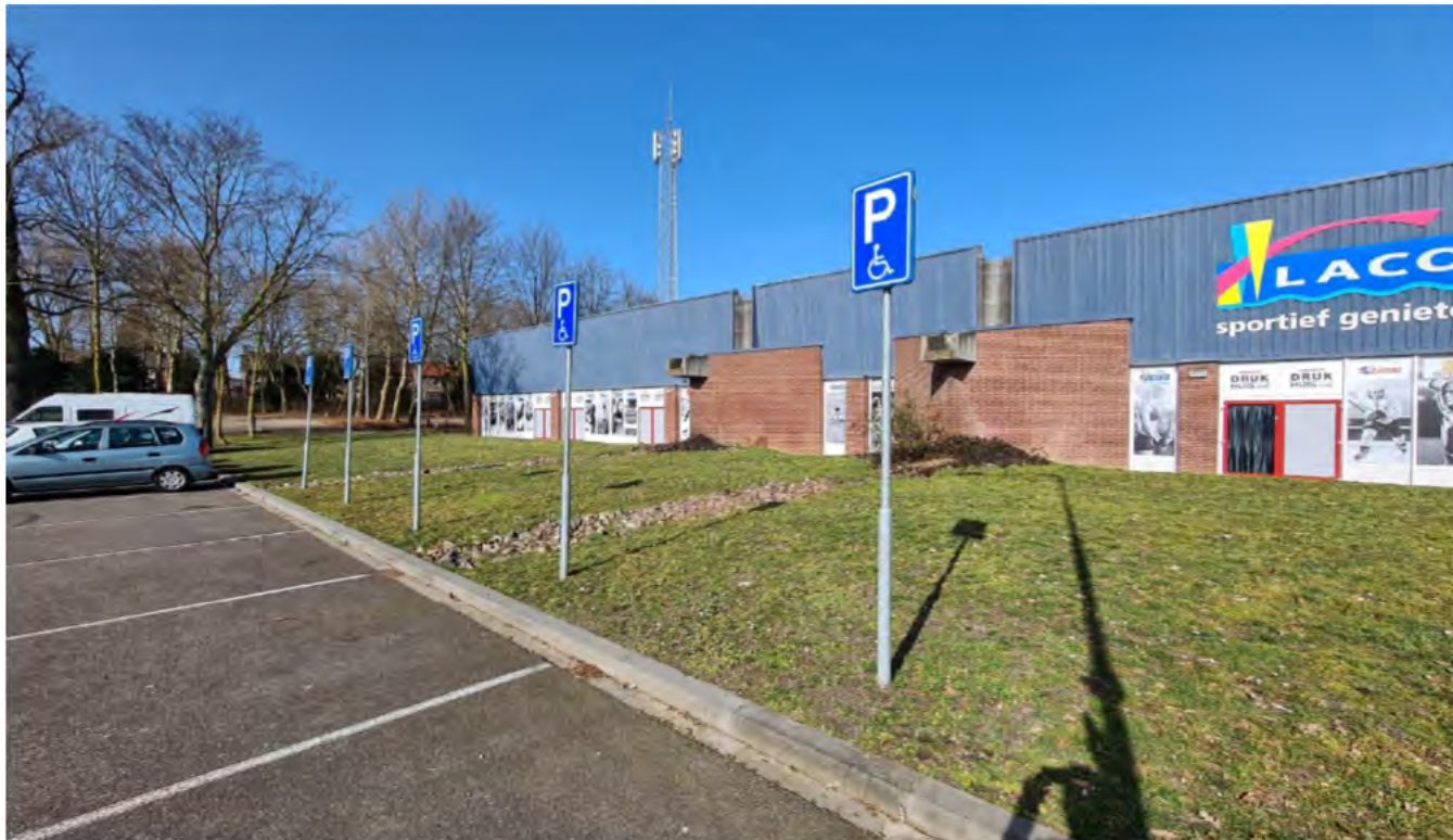
Figuur 1: Zuidelijke gevel bestaande sportaccommodatie gezien vanaf de zuidelijke parkeerplaats
