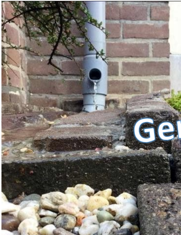
Afkoppelen van hemelwater in de voortuin
