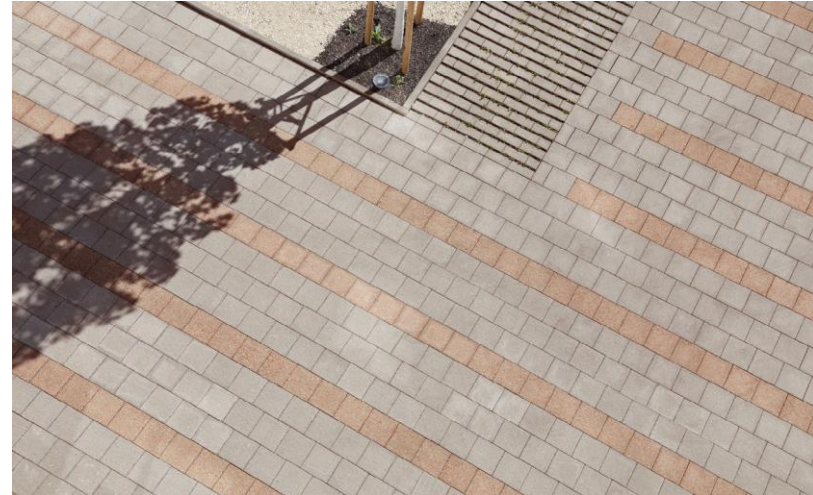
Betonstraatsteen redotto, 450x150x80 mm, 1/3de verband, natuurgrijs, leverancier: Metten Stein+Design
