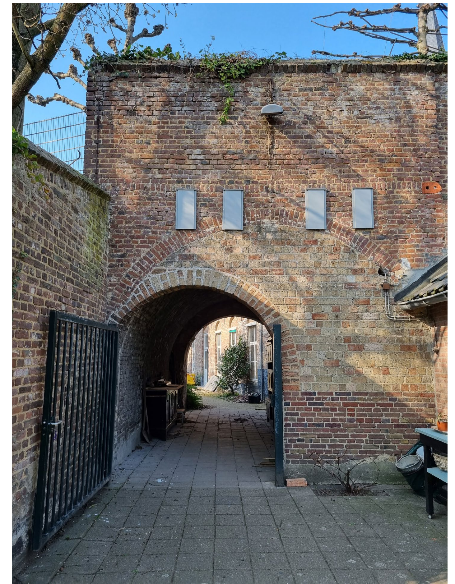
De doorgang in de wal vergroten naar oorspronkelijke afmetingen.
