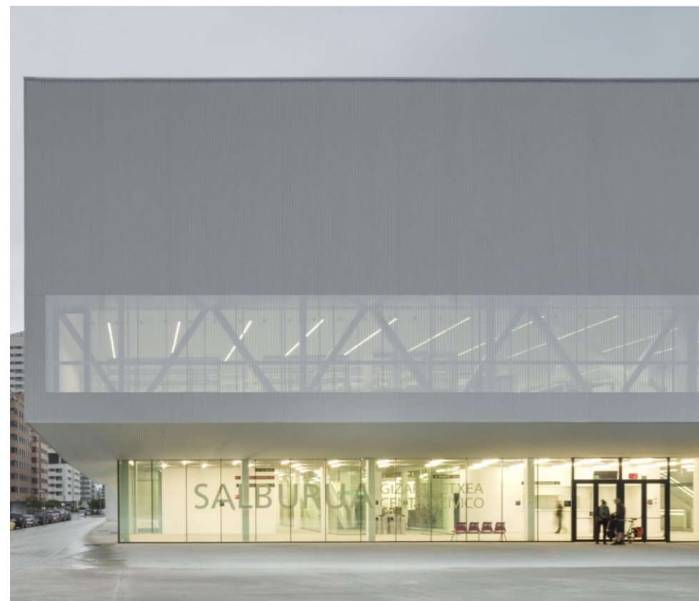
translucente gevel zorgt voor licht in bestaande zwembad
